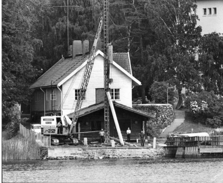
Liikelaitosten ja rakennusyritysten tasavallan presidentille lahjoittaman katetun uima-altaan pohjaa paalutetaan paraikaa Tamminiemessä. (KUVA: ENSIO ILMONEN)
